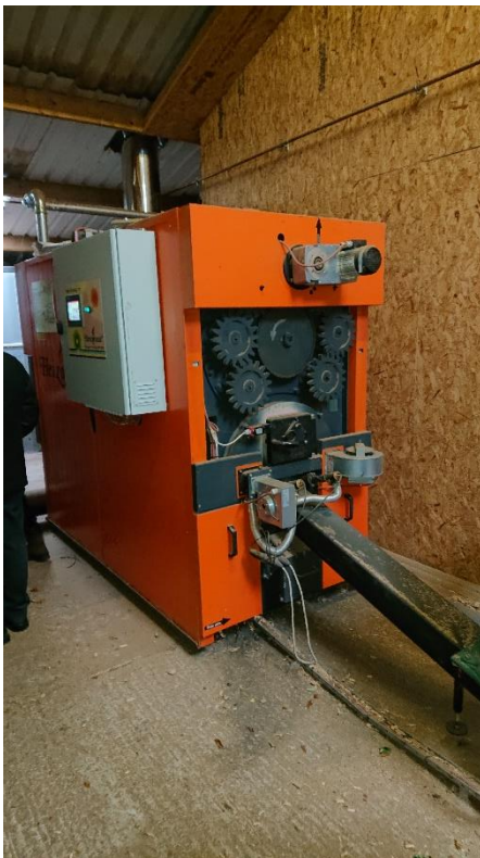
Värmepannan på Rottal Estate och hemmagjord flis
